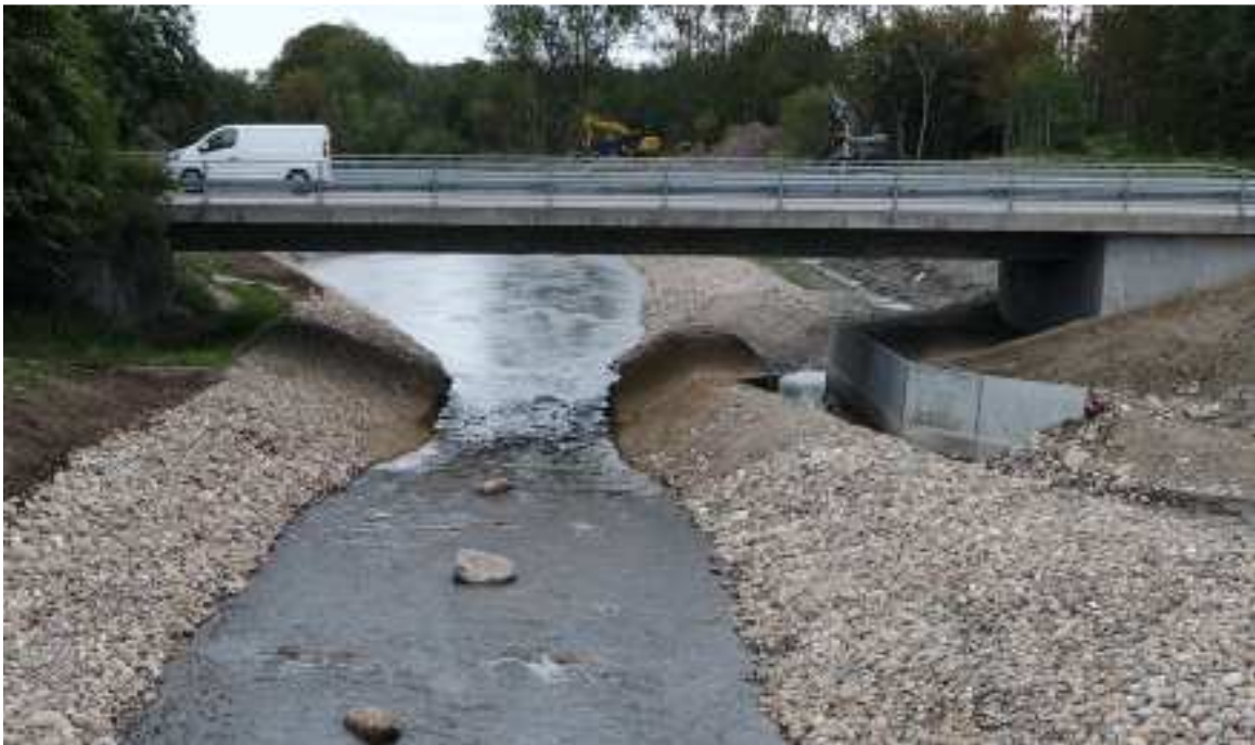
Beton L-elementer ses til højre (foto nedstrøms fra mens tegning opstrøms fra).
