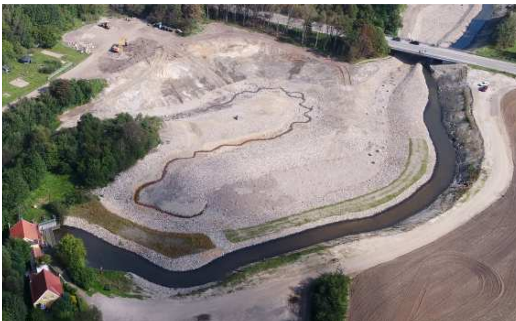
Dronefoto viser det udgravede sekundære profil nedenfor nederste gydebanke i nye å-forløb.
