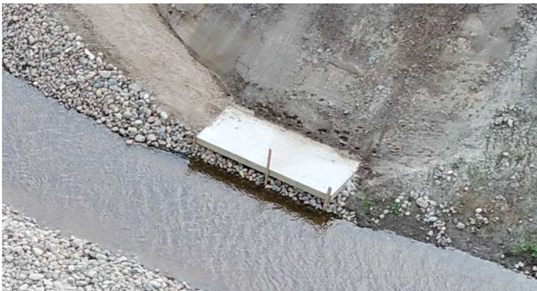
Ny betonbro nedstrøms indløbsbygværket til kanalen.
