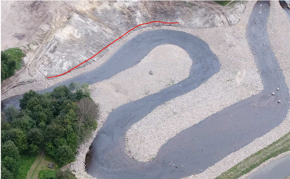
På strækning angivet med rødt er brinksikringen kun lagt op til 1 m over bundkoten
